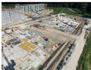
Neben dem Eisvogel befindet sich das **Baufeld Monarch (B)** in der Startphase. Die Aushubarbeiten für die sechs Gebäude werden im Juli 2020 abgeschlossen sein. Weiter ist die erste Deckenschalung in Arbeit und wurden die Wände der Untergeschosse betoniert. Von den ersten vier Gebäuden sind alle Bodenplatten erstellt. Die 60 Erdsondenbohrungen wurden praktisch alle erfolgreich ausgeführt.
